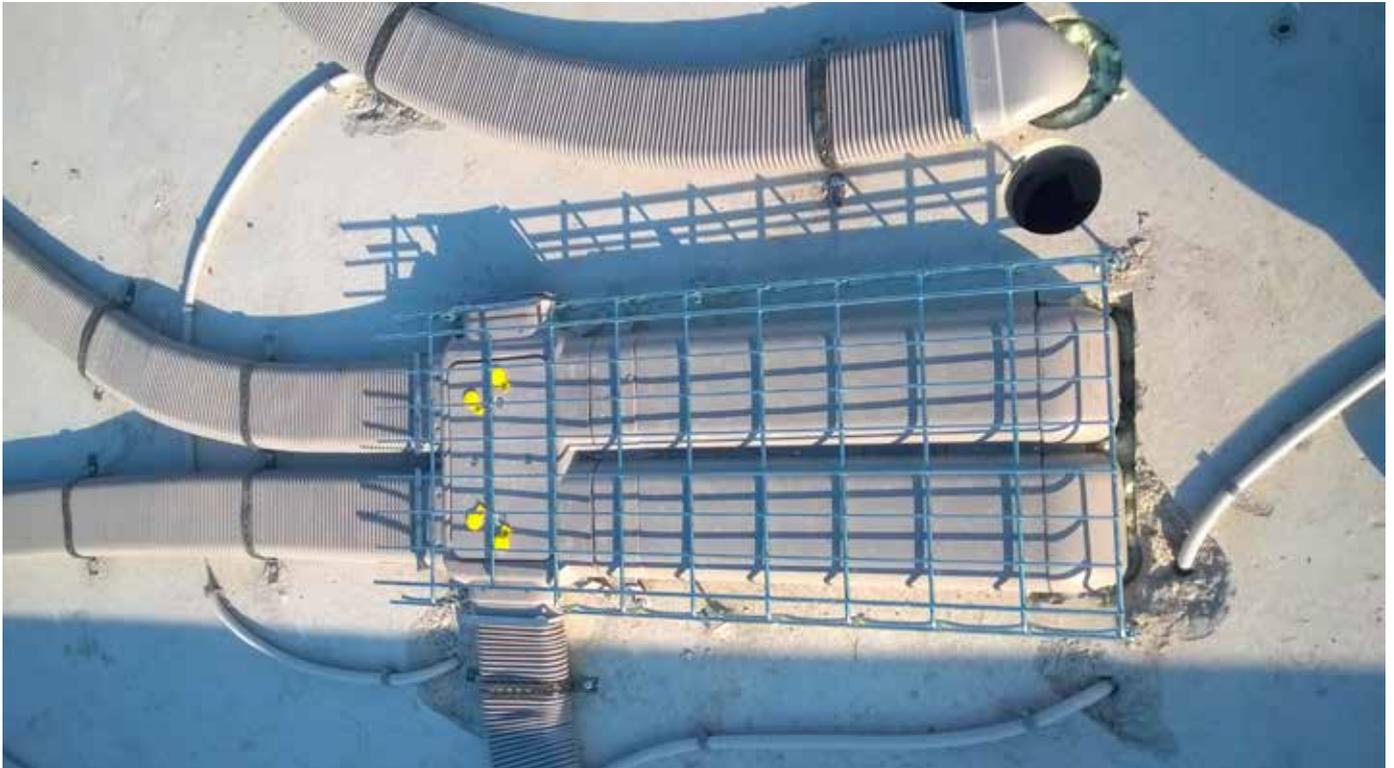
CK 300 gaine double (avec renforcement) - Distributeur ComfoFlat 51-4 et ComfoFlat avec CLRF
