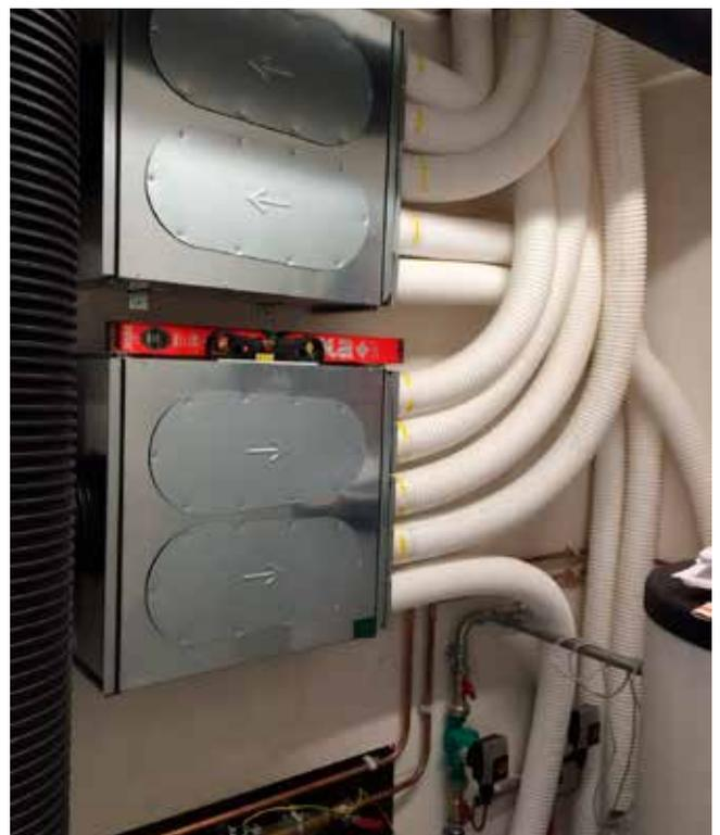
Caisson de distribution d'air comfowell avec silencieux intégré CW-S 520 + ComfoTube 90
