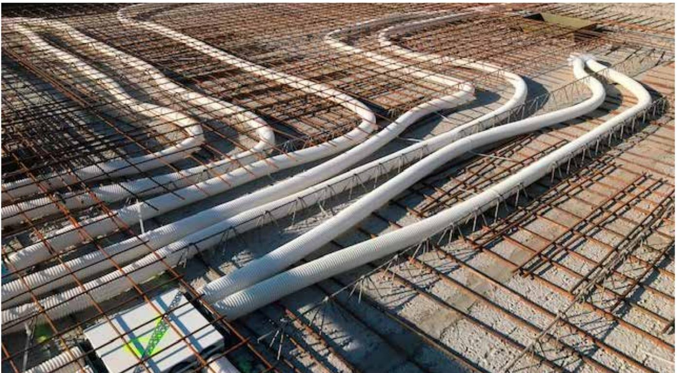
CT350 caisson de distribution avec ComfoTube 90 et TVA PE
