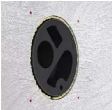
3. Enlevez l'obturatrice extérieure coque inférieure de nouveau et préparez pour les quatre points de fixation une technique de fixation appropriée selon la construction de façade.
