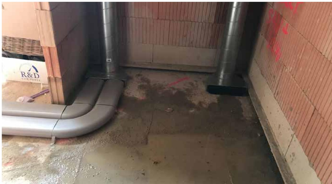
Système de distribution mixte: Gaines verticales en galva avec tube CK 300 passage équerre et CK 300 tube double.
